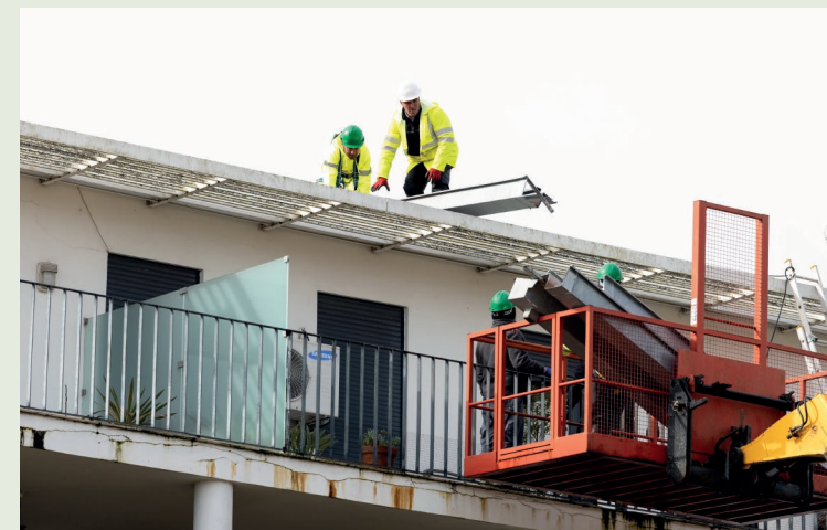
Entre os muitos trabalhos para apoiar as populações, esteve a estabilização do telhado de um dos edifícios da avenida dos Aviadores, feita por equipas municipais.
