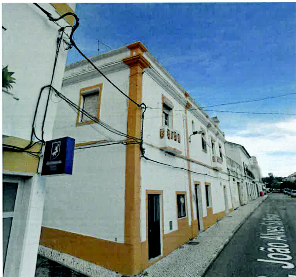
Imagem 5 – Edifícios do quarteirão a incluir na delimitação da ARU – vista sul.
