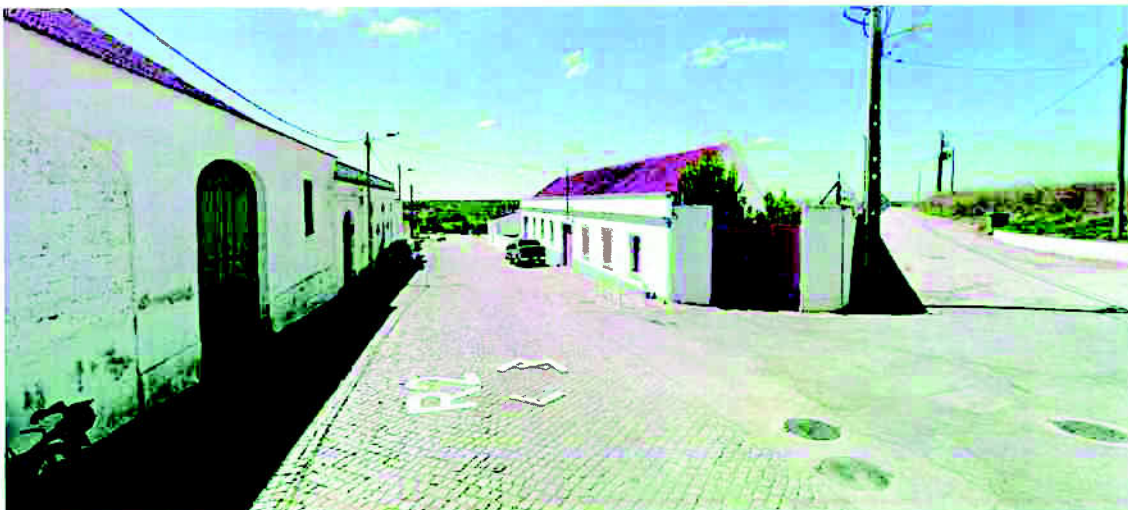
Imagem 4 – Edifícios na Rua de Beja, a incluir na delimitação da ARU.
