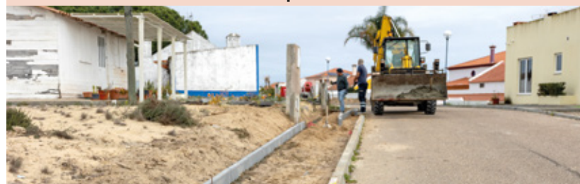
Instalação de passeios na Carrasqueira (2025)
