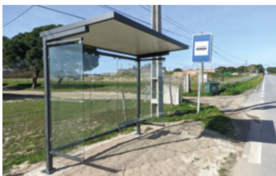
Instalação de novos abrigos de passageiros que vieram substituir os degradados (2023)
