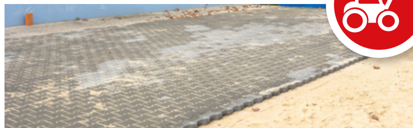
Instalação de passeios na Comporta (2025)
