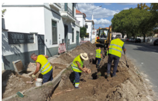
Remodelação da rede de drenagem de águas residuais domésticas na Rua do Cabo da Vila (2022)
